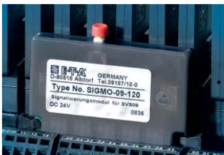
Mit integriertem Modul SIGMO-09-100: Eine Einzelsignalisierung pro Steckplatz und eine Summensignalisierung pro SVS09-Kaskade. Lokale oder Remote-Quittierung z. B. von der Leitwarte.
